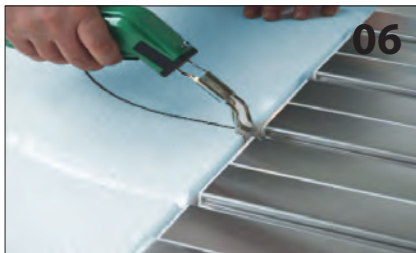
06 Individuelle Rohrführungen z.B. vor dem Heizkreisverteiler oder bei Einbauten, usw. können mit dem Heißschneidegerät aus den Schaumstoffplatten geschnitten werden.
